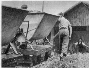
Sous un hangar, voici le système tracteur : moteur, treuil et câble.
